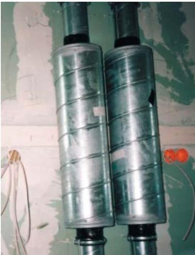
*Schalldämpfer im Rohrnetz einer Zu-/Abluftanlage. Das Rohrnetz muss aus glatten Materialien mit geringem Strömungswiderstand bestehen (hier: Wickelfalzrohr).*
